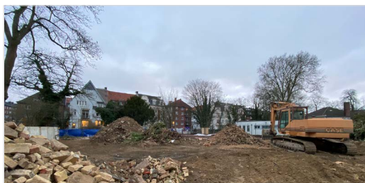
Baustelle am Schlossplatz 16, Ecke Lazarettstraße im Winter 2021/2022
